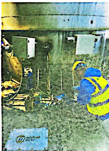
K2线窑尾废气处理设施排气筒
